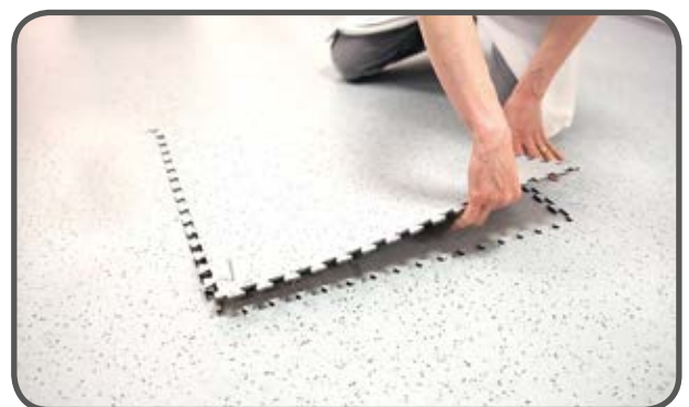
Beschädigte Fliese raus / Neue Fliese rein
